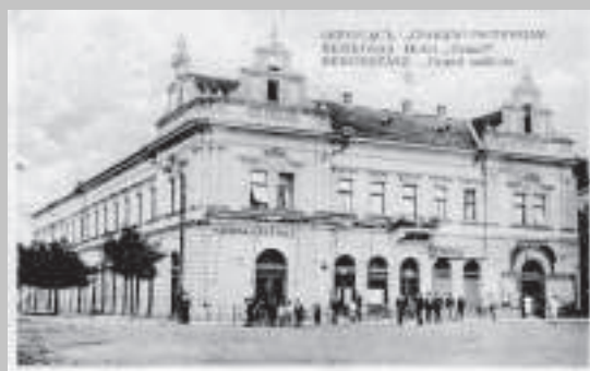
A Beregszász főterén álló egykori Grand Hotel (ma a Rákóczi Főiskola kollégiuma) egy 1920-as évekből származó képeslapon, három nyelvű szöveggel
