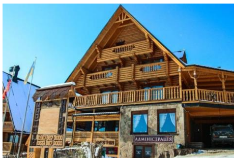
Рис. 1 Готельний комплекс «Карпати»
