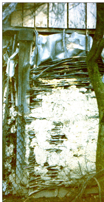
9. kép. Talpas-vázásól vízszintesen fonott fala (A szerző felvétele) A függőleges karók, jól láthatóan, a koszorúgerendához és a talpgerendához vannak szegezve. Korábban, igényesebb megoldásként a karók végeit a talp- és koszorúgerendába fúrt lyukakba illesztették.
