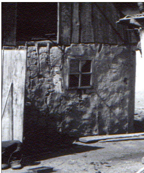
10. kép. Régi ház jól látható ticsos fala (Dincsér Oszkár felvétele)
