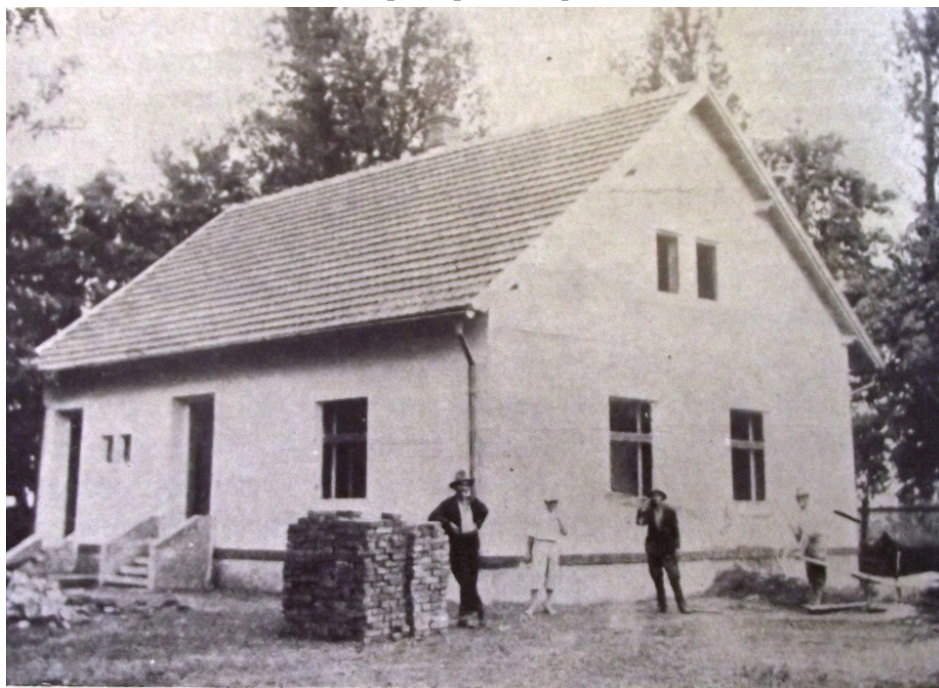
13. kép Telepes ház építése
