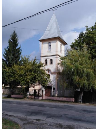
5.ábra. Benei római katolikus templom
