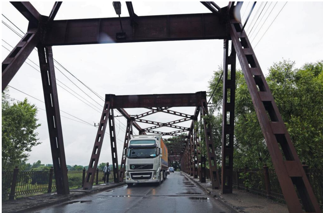
18. ábra: A Tiszán átívelő, kulcsfontosságú híd.
