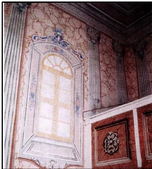
12. ábra. Barabás, református templom. Az északi fal befalazott keleti ablaka az 1866-ban készült illuzionisztikus festéssel (SIMON A., 2002).
