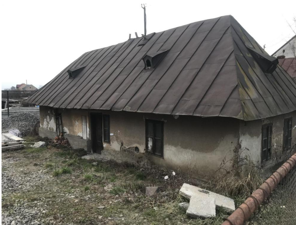
27. fénykép. Vályoggal épült lakóház, szarufás tetőszerkezetét bádoggal fedték le (Fotó: Iszák Dzszenifer, 2021.)
