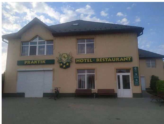
Рис. 2.1: Будівля старого корпусу
