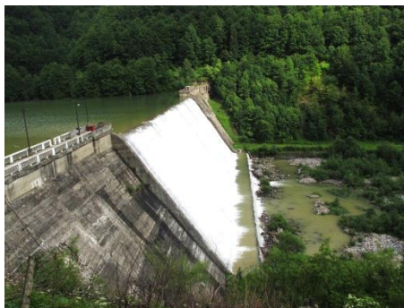
80. ábra. A Talabor-Nagyági Vízerőmű gátja a Talabor folyón
