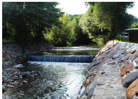
81. ábra. Partkövezés a Viznice-patakon
