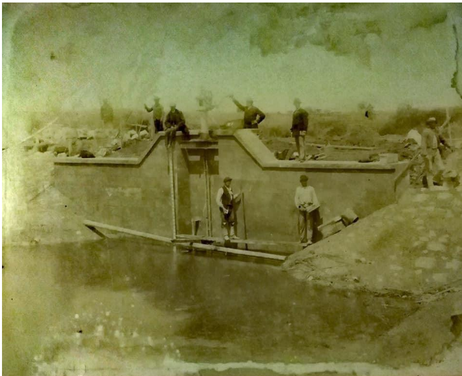
12-13. kép: A Borzsa folyó duzzasztó gátjának építése és elkészült állapota
