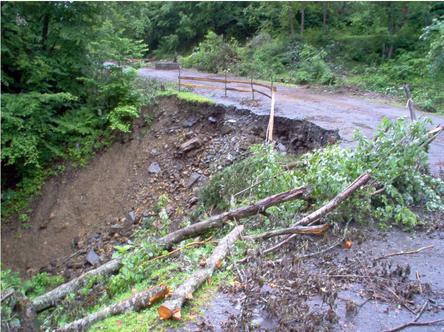
31. ábra. A talaj kimosódása által megsérült úttest a Talabor völgyében, a Talabori víztározó mellett (Husztai járás)
