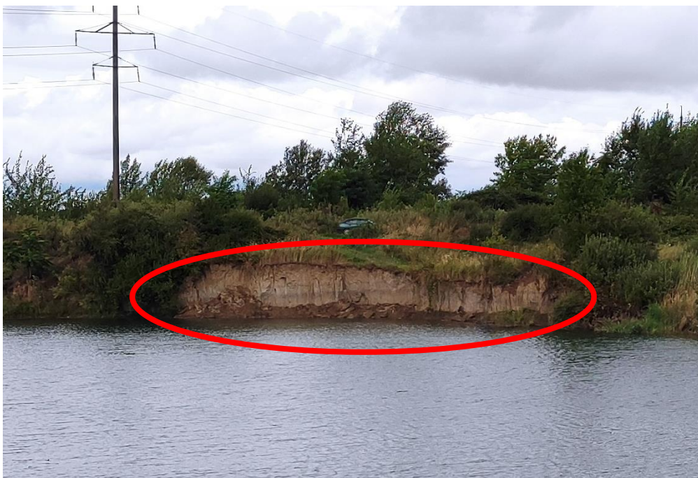
3-4. ábra. A kitermelés és a nagy esőzések miatti leomlás szemléltetése a 2. sz. bányatónál (Forrás: Saját felvételek)
