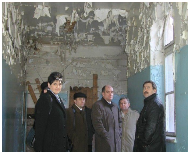
4. ábra Az egykori Törvényszéki épület felújítása
