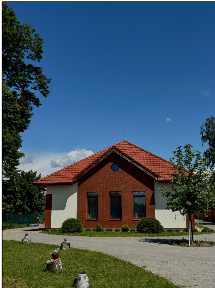
20. ábra: Az óvoda épülete (saját felvétel, 2025).
