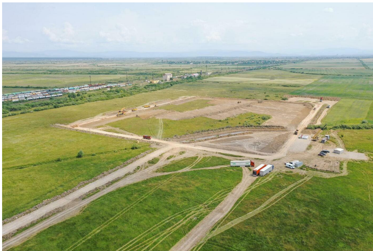
5. ábra Építkezési munkálatok a "BF Terminál" területén.
