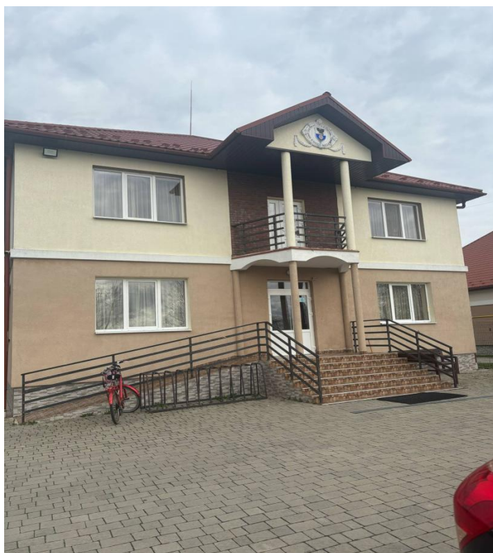
9. ábra. Nagydobronyi Egán Ede Szakképzési Centrum épülete
