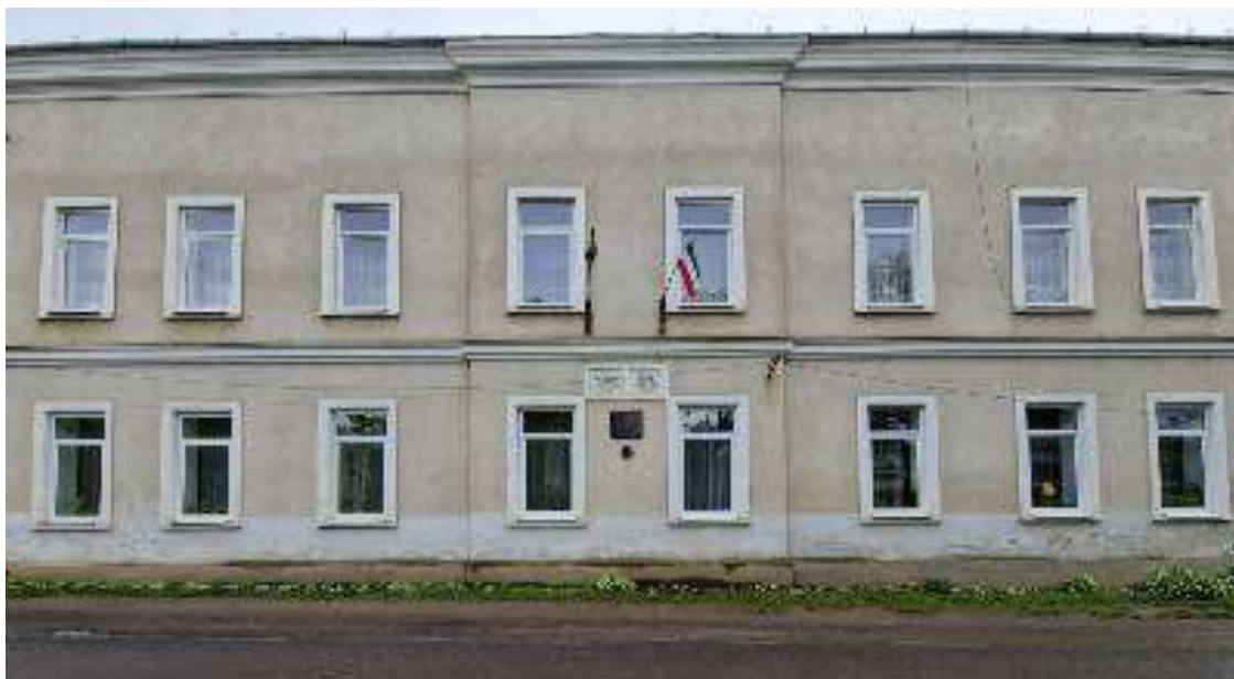
2. kép: A Beregrákosi Gimnázium épülete (saját kép)
